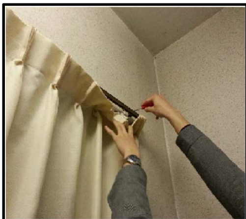
図 3-49 レールの取り付け
