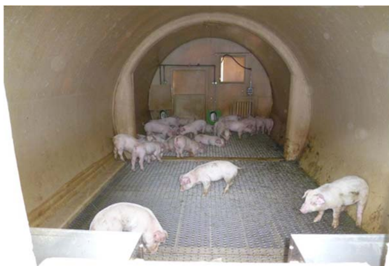
図 4.2 実験 A：畜舎内部
